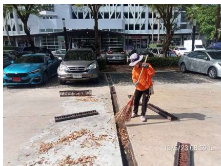
รูปที่ 24 ทำความสะอาดรางระบายน้ำ
